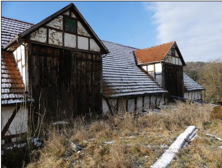
Abb. 4: Rückseite Stallgebäude, Blick nach Nordwesten (15.01.2021)
