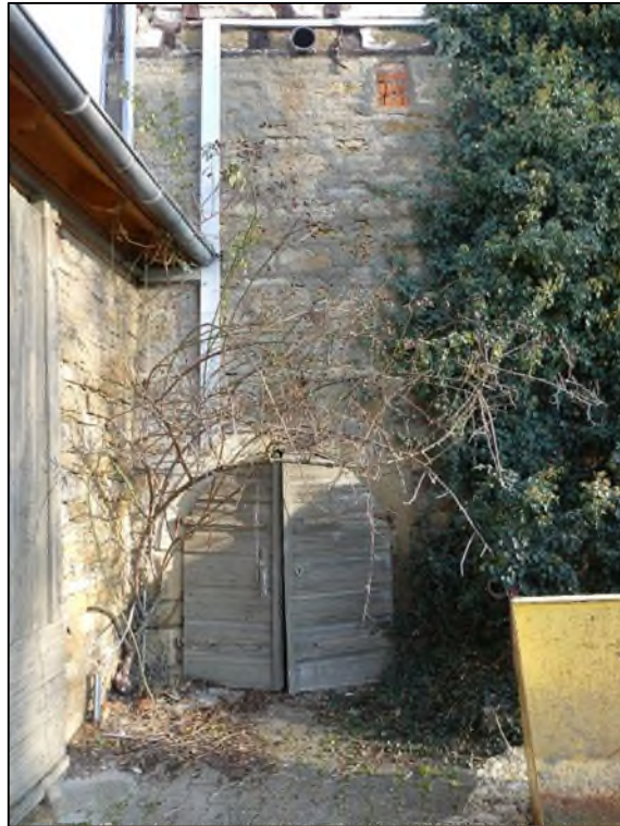
Abb. 8: Untergeschoss Stallgebäude, Eingang zum Gewölbekeller (15.01.2021)
