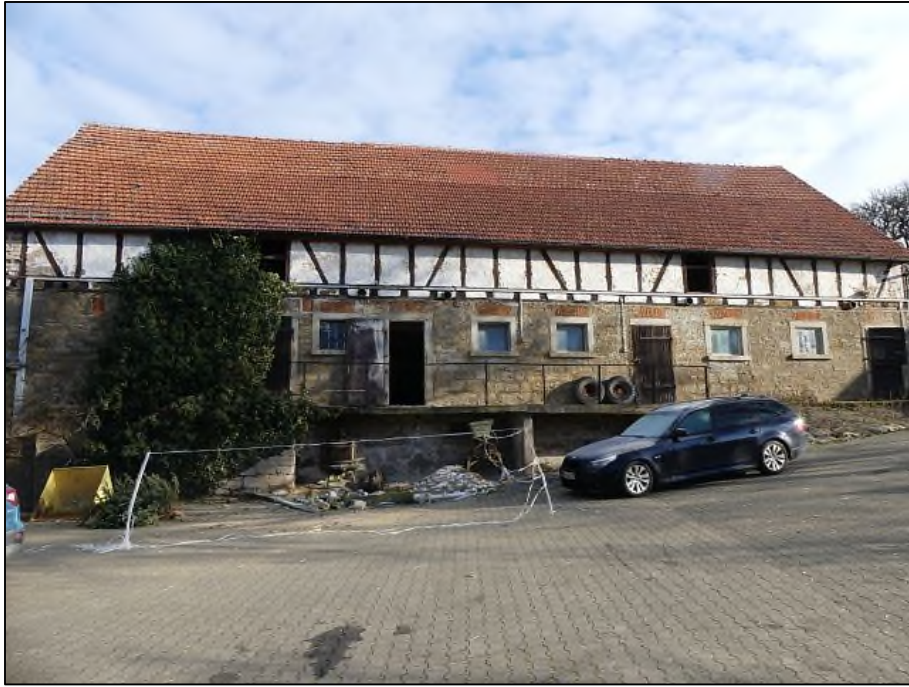
Abb. 3: Stallgebäude, Ansicht von Südwesten, (15.01.2021)
