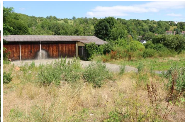
4 Ruderalfläche, Blick auf die Lagerhalle © Klärle GmbH, 16.7.2024
