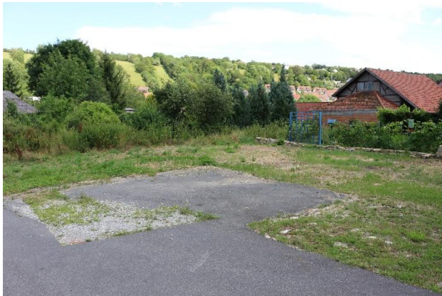
3 Abgebrochenes Anwesen Nr.40 © Klärle GmbH, 16.7.2024
