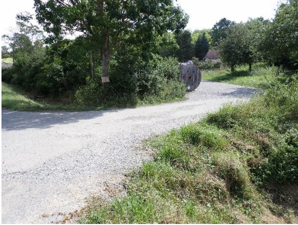
Foto 1: Bestehende Zufahrt am Ostrand des Gebiets
